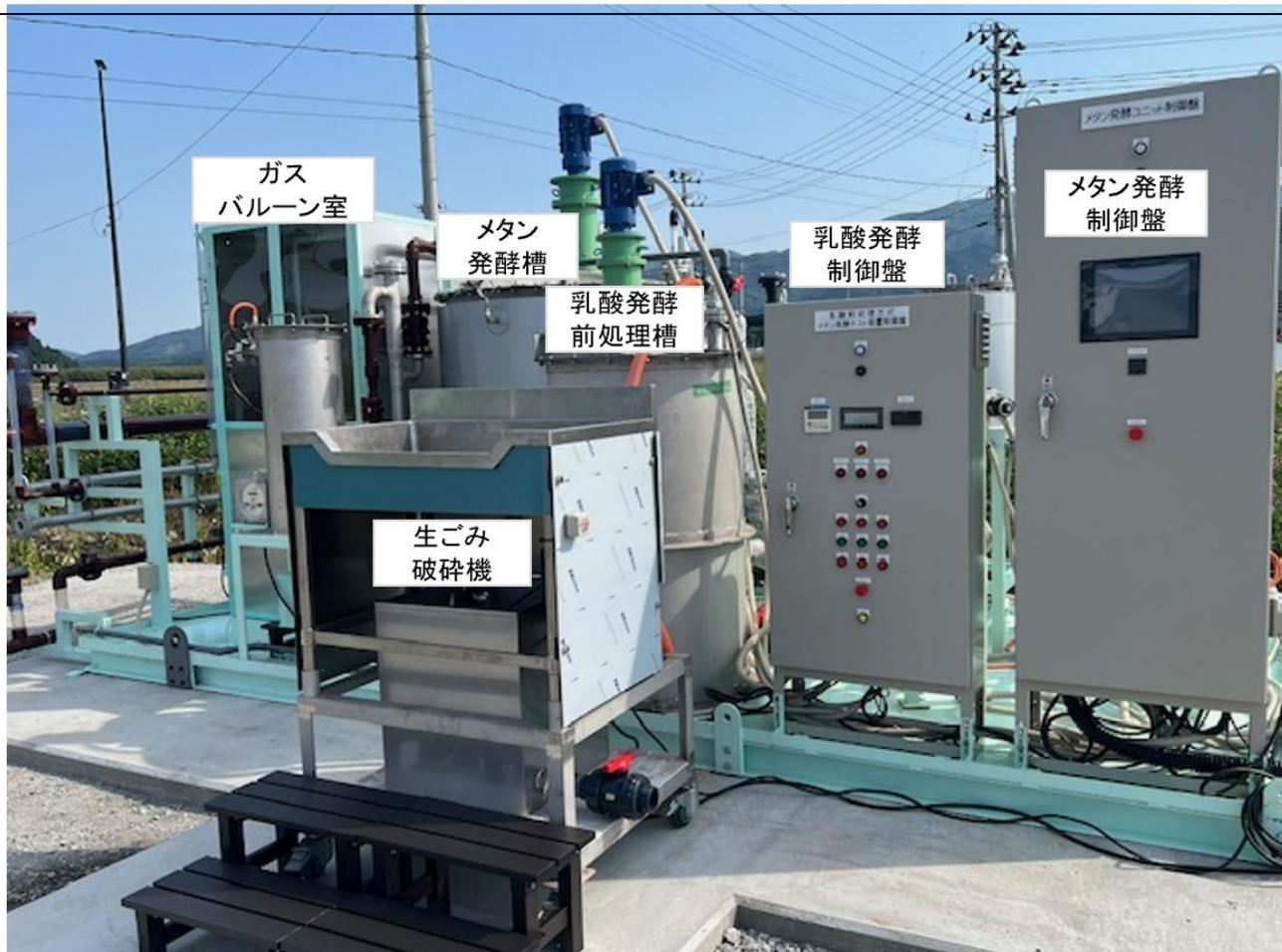
陸前高田市の導入した乳酸発酵前処理ならびにメタン発酵実証機（原料は生ごみと汚泥）
