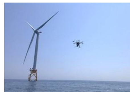
UAVによる臨時点検のイメージ
