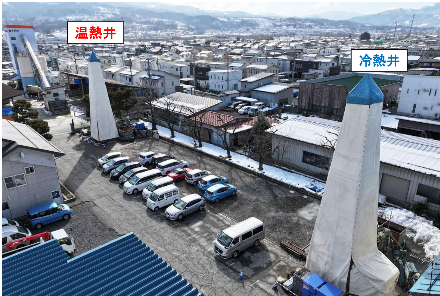
2/27 井戸掘削状況全景(敷地北西側からドローンで撮影)
