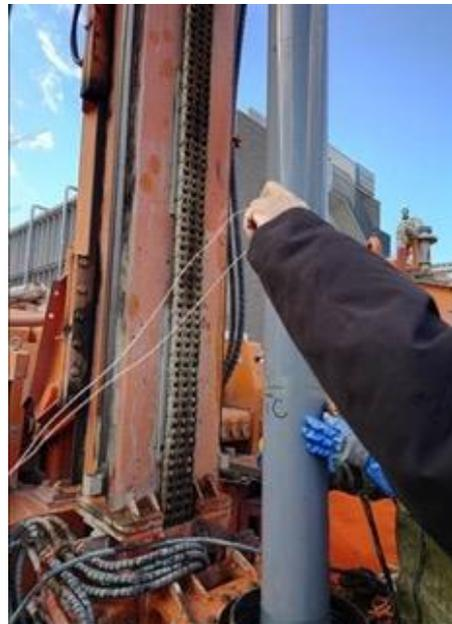
内管挿入時の熱電対設置作業
