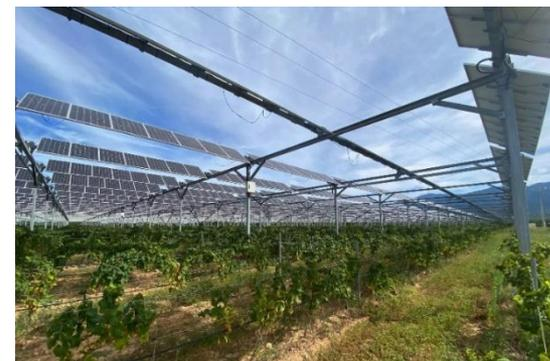
可動式太陽光発電システムのブドウ畑への設置例
