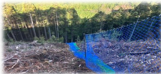
防獣ネット設置
