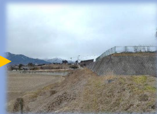
支障木（施工後）
