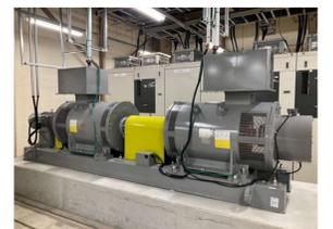
M-Gセット、再エネ模擬装置、蓄電池模擬装置(いずれも100kVA)により構成
