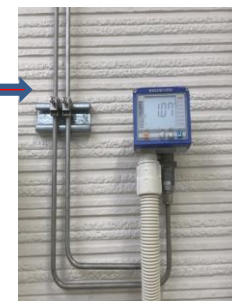
CO 2 配管及び監視用流量計
