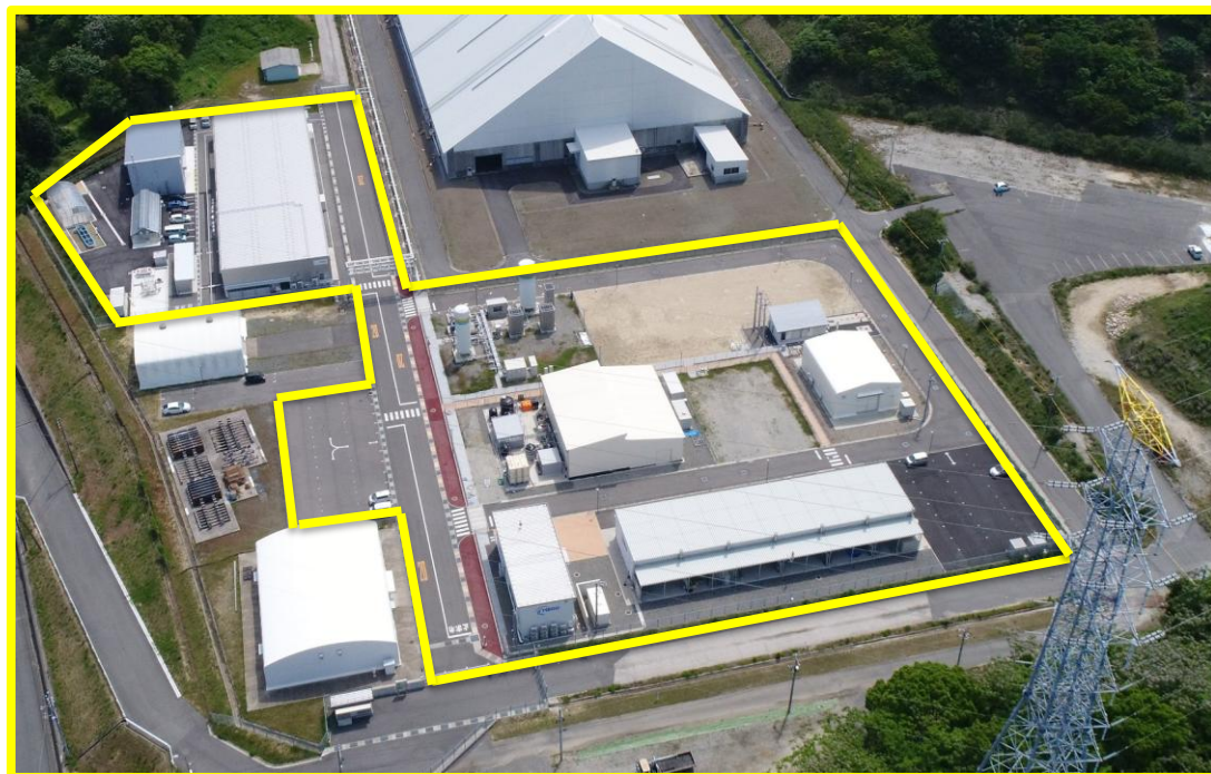
CR実証研究拠点全景
