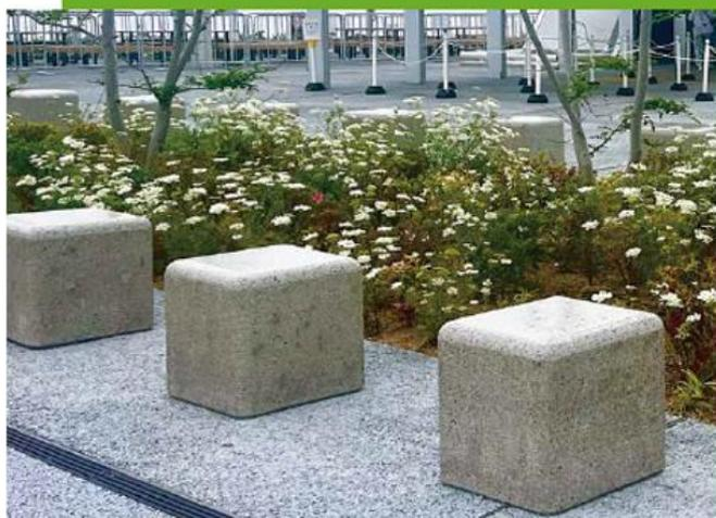
東京都板橋清掃工場やいぶきグリーンエネルギーバイオマス発電所から排出されるバイオマス由来のCO<sub>2</sub>を床板ブロックやベンチに吸収・固定させています。未来のコンクリートの提案です。
