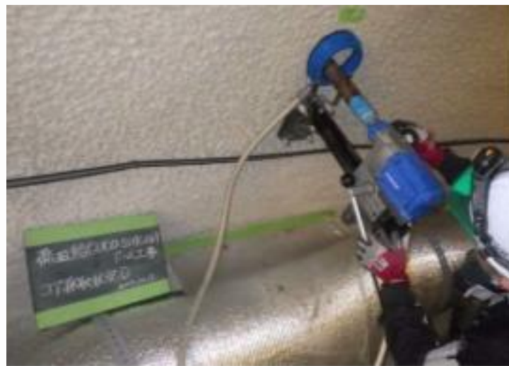
試作ドーム（東京）コア抜き状況
