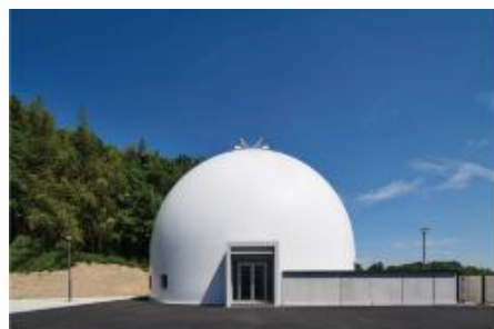
ドーム建築物 施工技術
