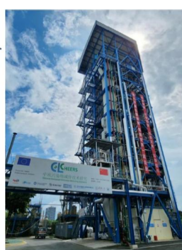
図. 清華大の実証装置外観 場所: 四川省徳陽市、東方ボイラ試験場 規模: 4MW th (現時点、世界最大) 高さ: 総高さ48m(16階建物相当)
